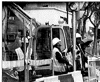
Obreros de la construcción en una obra de Madrid. M.C.
