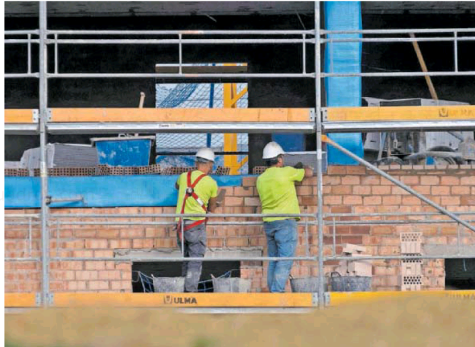
Una construcción en Sevilla en noviembre. PAGO PUNTES
