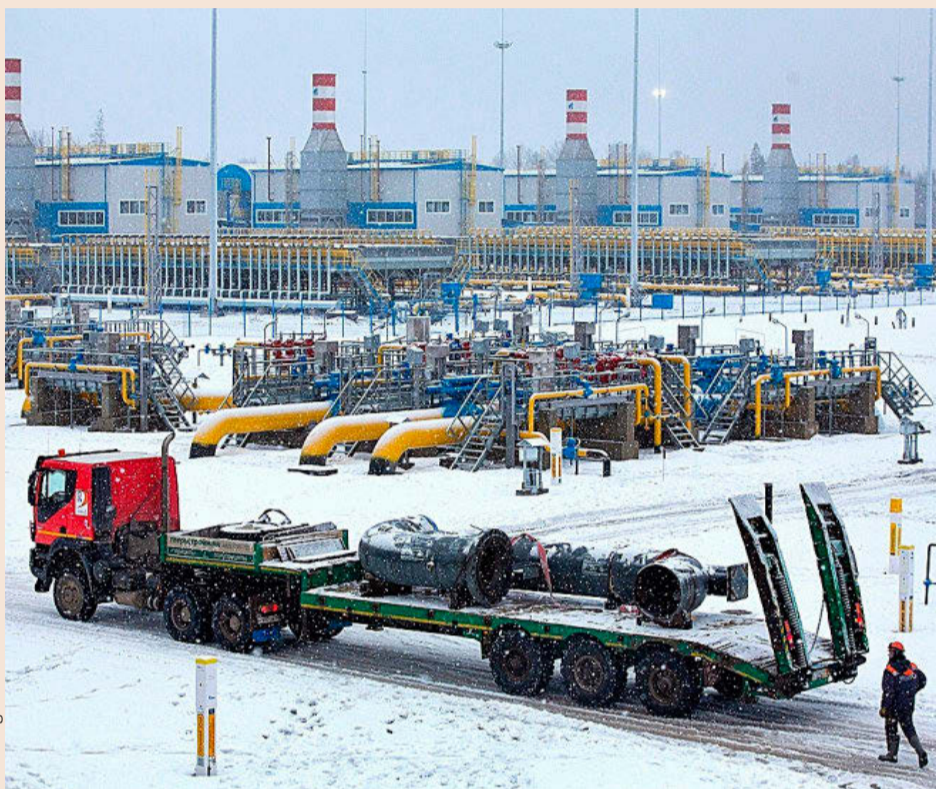
Instalaciones del gasoducto Nord Stream 2 en Ust-Luga (Rusia).
